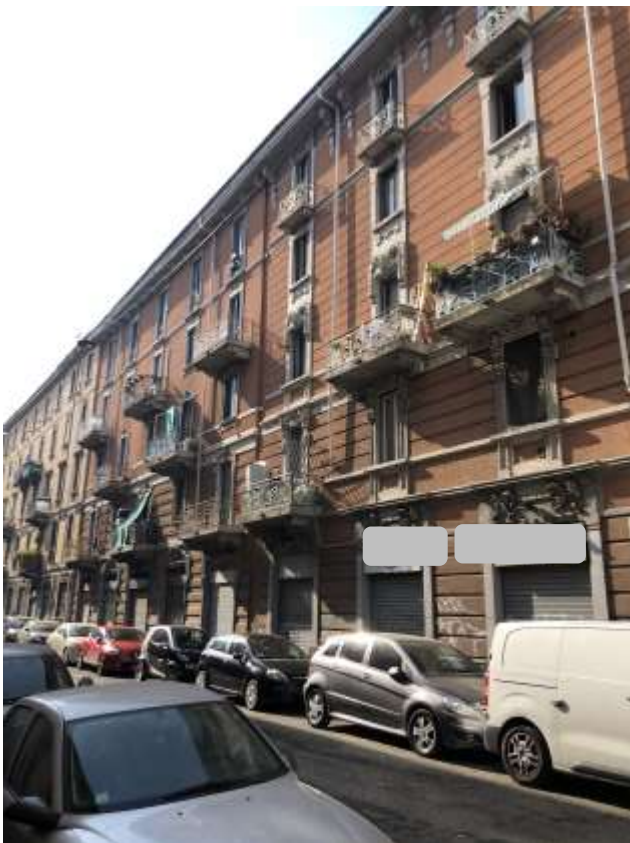
Viste dello stabile da Via Privata Conegliano
