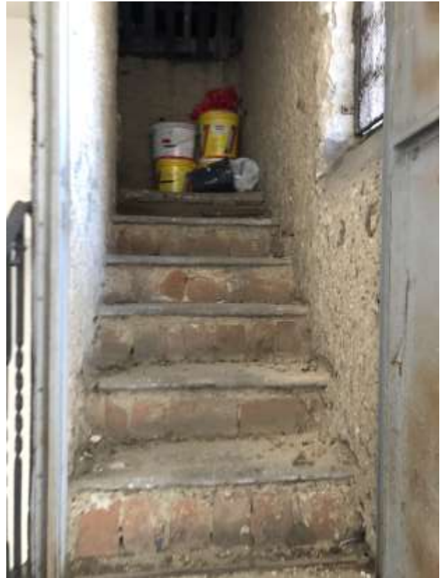
Vista scale al solaio
