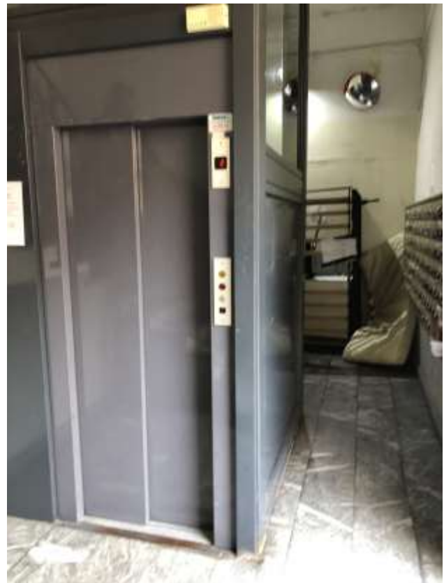
Vista vano ascensore
