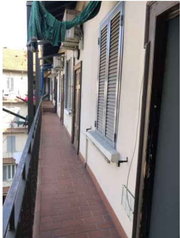
Vista ballatoio comune
