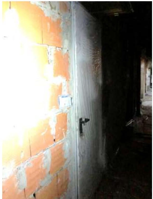
Vista porta solaio di pertinenza
