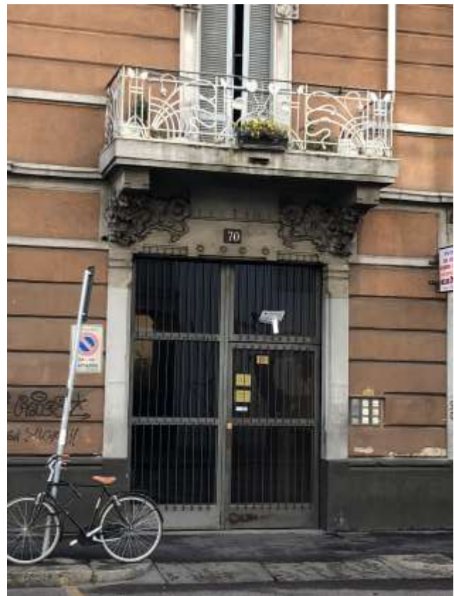
Vista portone di ingresso civico n. 70
